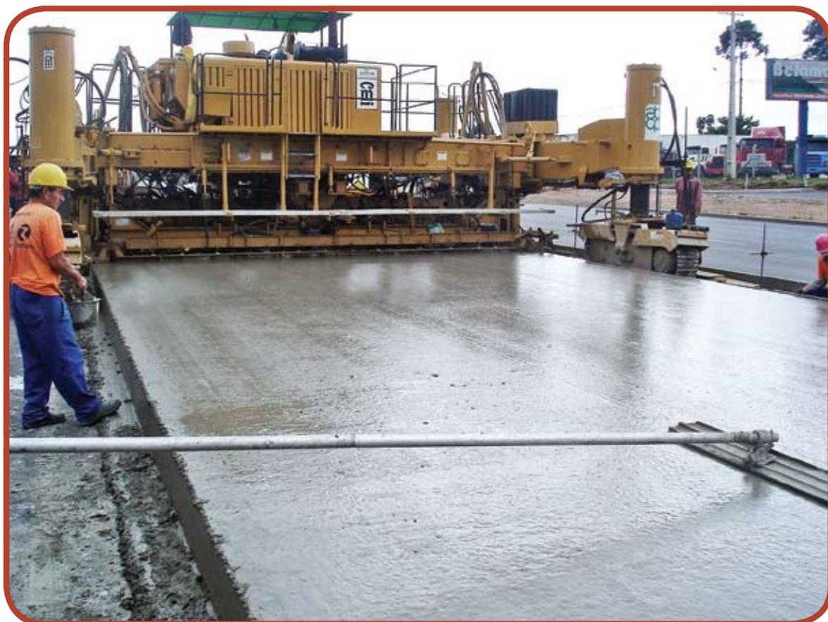
Figura 6 - Pavimentadora Terex-CMI (Mod. SF3004)
