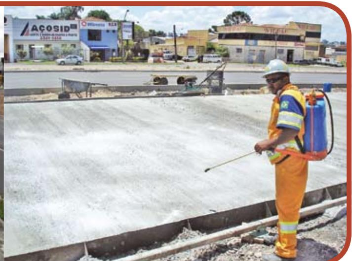
**Figura 10 - Aplicação do produto de cura química com equipamento autopropelido e bomba espargidora costal**
