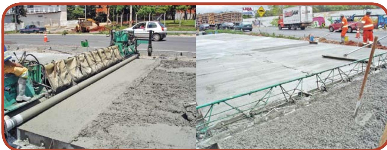
Figura 7 - À esquerda Rolo Vibratório e à direita Régua Treçada Vibratória
