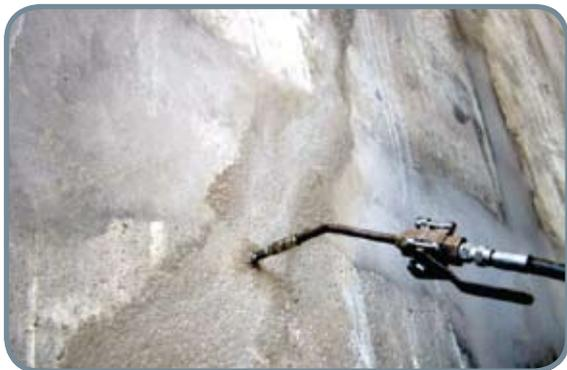
*Vista da injeção de epóxi em fissura de um pilar da catedral*
