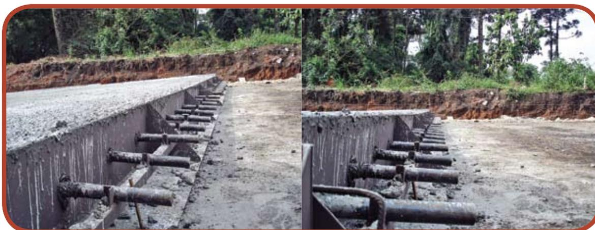
Figura 11 - Detalhe da junta transversal de construção com forma
